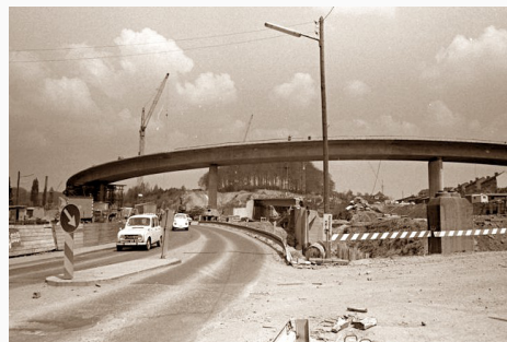
Baustelle Sonnborner Kreuz 1971 (Foto: Bundesarchiv, Wegmann)
