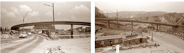
Zeitgenössische Postkarte, Baustelle des Sonnborner Kreuzes
