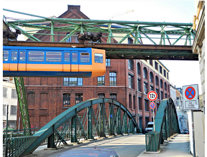
Arrenberg Tannenbergsstraße, Klinikum Arrenberg Haus 3, Brücke Moritzstraße
