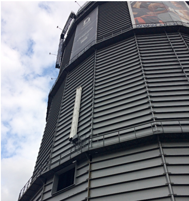
Alter Gaskessel in Heckinghausen
